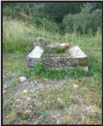
Manuel Francisco Bueno Álvarez Situación actual del antiguo lavadero
