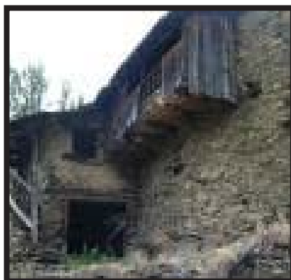
Casa antigua con su típica pared de piedra y su corredor de madera.
