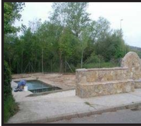
Fuente y lavaderos restaurados
