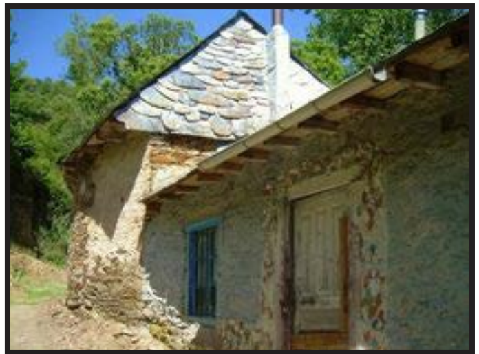
Una vivienda que han empezado a reconstruir
