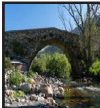
El otro puente
